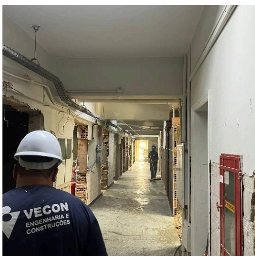
Demolição das alvenarias existentes e construção das novas alvenarias.
